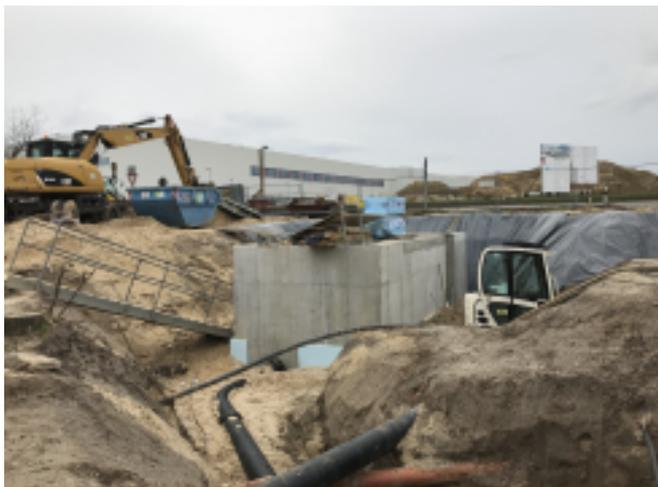
Reaktion auf eine solche Havarie zu schaffen, wird das genannte Havariebecken mit einem Volumen von ca. 250 m<sup>3</sup> gebaut. Das dort bereits bestehende "Pumpwerk Pötter" wird in dem Zusammenhang ebenfalls umgebaut. ■
